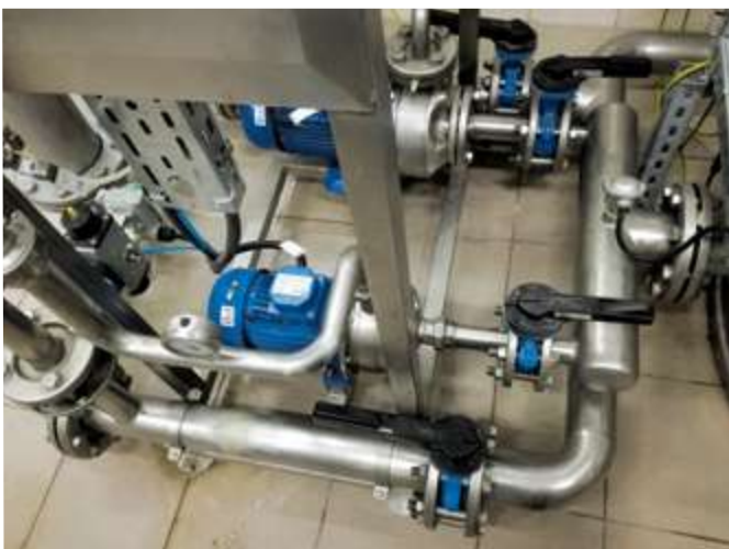
Przepustnice ręczne oraz przepustnica sterowana napędem pneumatycznym z powrotem sprężyną, firmy OMAL.
