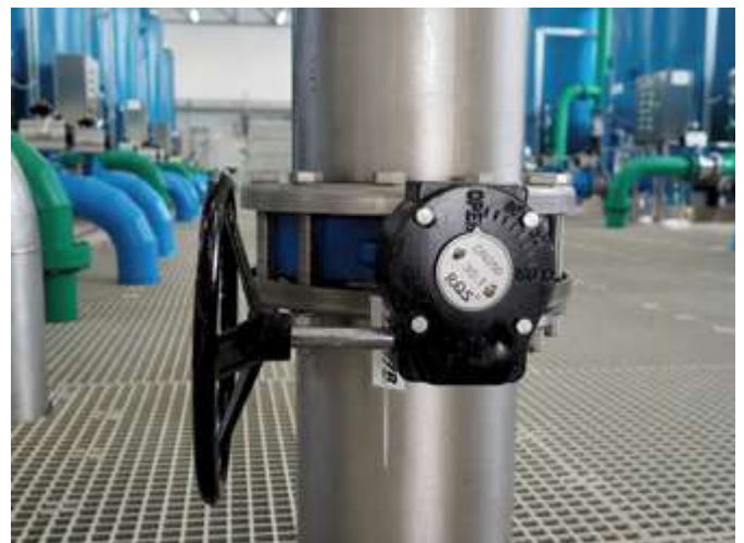
Przepustnica RQS serii 600 o średnicy nominalnej 250 mm z zamontowaną przekładnią ślimakową.
