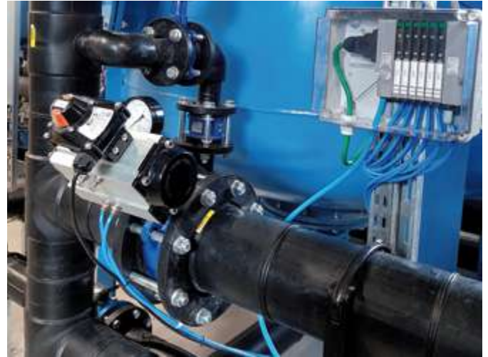
Stacja uzdatniania zautomatyzowana napędami zębatkowymi RQS, zamontowanymi na przepustnicach serii 600, sterowanymi z wyspy zaworowej OPTYMA-S firmy PNEUMAX.
